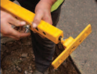
Tighten wing nut on bolt.
